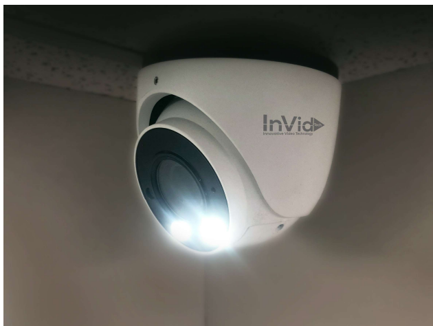
PAR-P2FACETX2812G1: Así se ve una cámara de luz blanca cuando está encendida.
